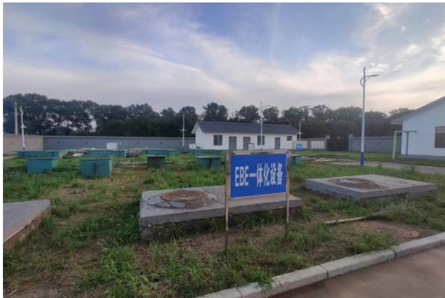
图 5 污水处理设施封闭措施
