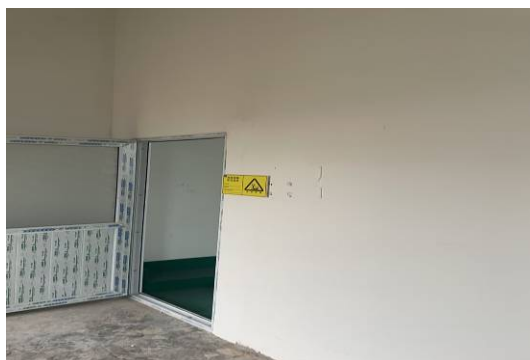
危废暂存间外部
