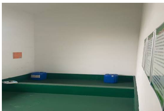
危废暂存间内部
