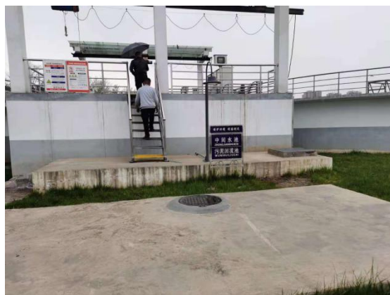
污泥池及中间池
