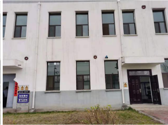
细格栅间及曝气沉砂池
