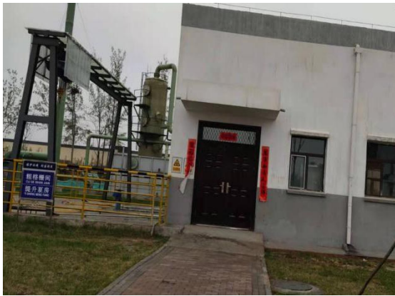
粗格栅及进水提升泵房
